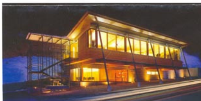
KlimaHaus A+: Das Verwaltungsgebäude der Firma Holz Pichler in Birchabruck
